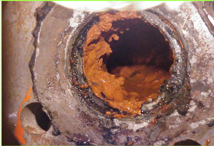
SCALECatcher 를 설치하지 않은 상태.(1998.12.22.현재) 감압밸브 후단의 배관으로서 사진 좌측으로 상당히 많은 Scale 이 보이고 있습니다.
