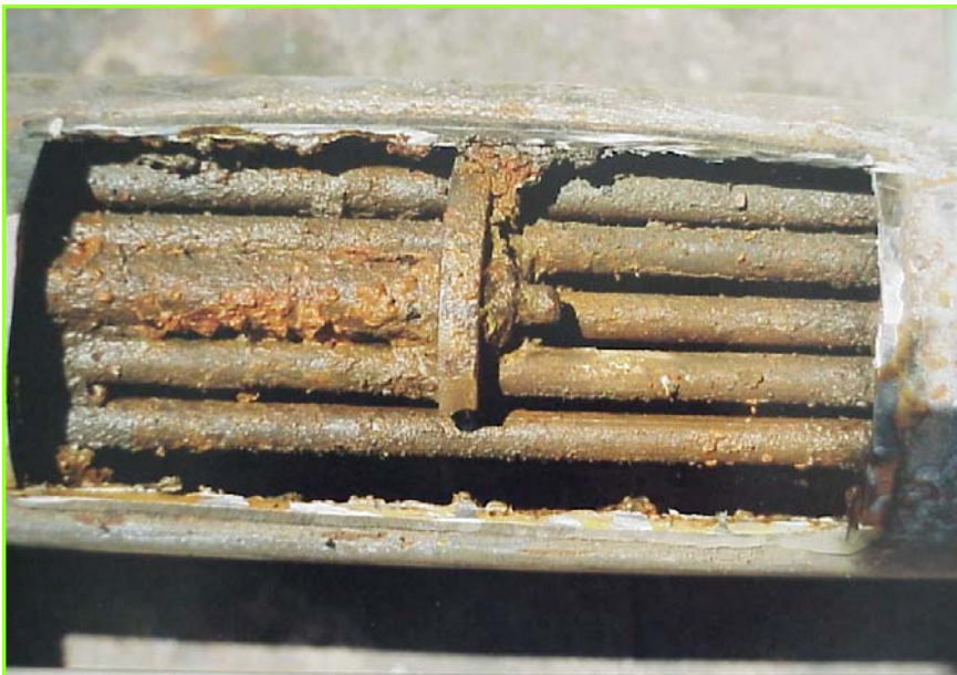
제 2 화성공장 Air Compressor After Cooler (1999.5.25.Test 완료) 3개월간의 Test 결과 Cooler 내부의 Scale 과 이물질이 거의 제거 되었으며 제거는 계속될 것입니다.
